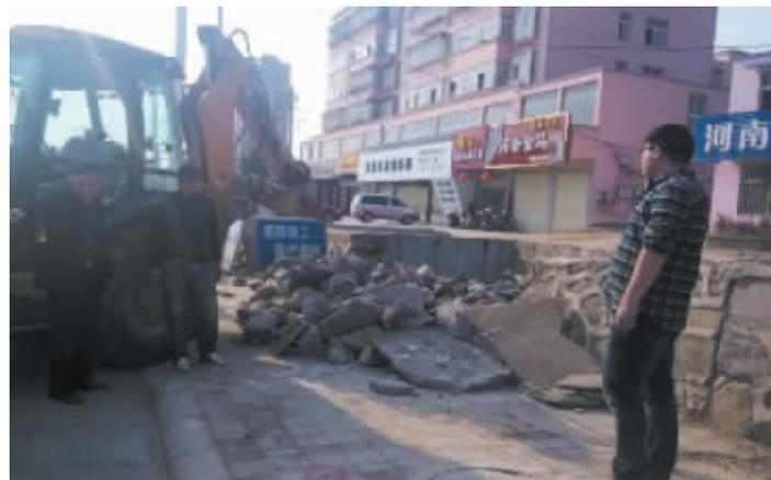
日前,新六大街与中环立交桥积水点改造工程正式施工。据介绍,为防止汛期内河倒灌,此处改造工程将原来直径为1.2米的管道全部改换成3x1.3米的板涵,工程全长340米。工程完工后将大大提升我市防汛排涝能力。 本报记者 黄慧 摄
