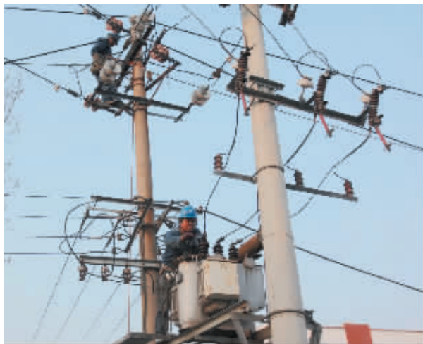
3月25日至29日,信阳供电公司将对10千伏五21线及五5线开展节能改造,全线更换架空绝缘导线及线路金具。节能改造将降低两条线路的线损率,并大大提高附近供电区域夏季的供电可靠性。 杨帆 摄
