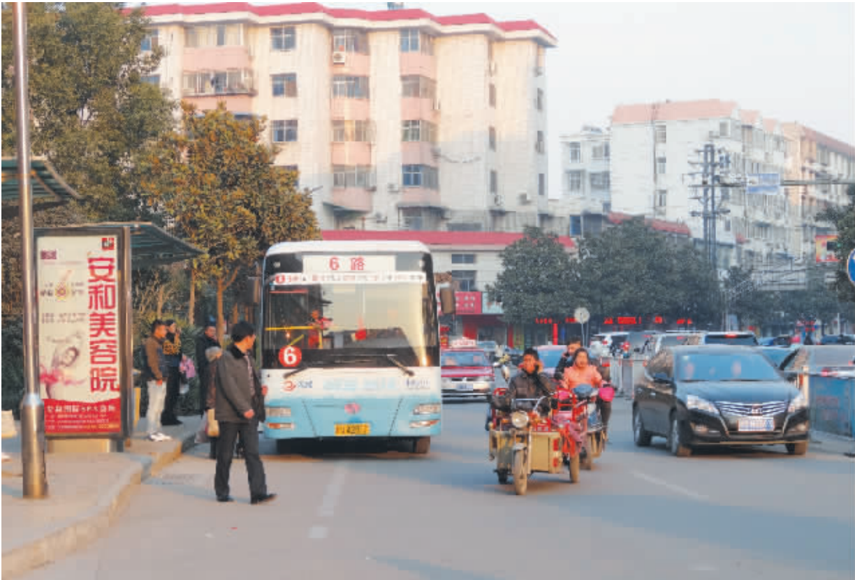
图为一辆6路公交车在申桥北进站。由于申桥北不是凹进式或者港湾式站点,公交车进站时,占据了一部分道路,使道路的通行能力降低。
