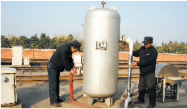
随着气温逐渐下降,为了确保旅客列车检修工作正常进行,武昌客车站段信阳运用车间对生产设备进行了防冻处理。图为 1 月 13 日,该车间人员正在给储风缸捆扎防冻棉。方昉 摄
