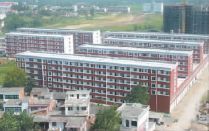
信阳市商城县美人岗廉租房小区全貌
