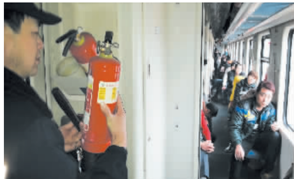
为确保旅客列车运行安全,武昌客车车辆段信阳运用车间加强了列车运行途中的安全卡控,落实巡视制度,对列车运行状态、安全监控装置及旅客服务设施进行实时监控,确保旅客乘车安全。图为12月24日,该车间乘务员正在检查车厢灭火器。 方昉 摄
