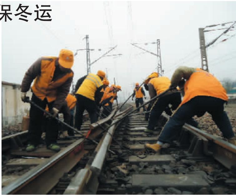
进入12月以来,信阳工务段组织精兵强将对管内干线及枢纽站场的设备进行全面检查整修,全力确保冬运安全。图为该段职工正在对管内139#伤损道岔进行更换。
