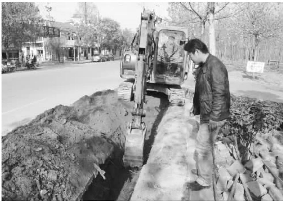
12月11日上午,游河南岸肖家河附近,燃气公司的施工人员正在铺设燃气管道。据施工人员介绍,为了保障肖家河村至信阳市委党校沿线的居民用上天然气,信阳市富地燃气公司在此铺设新的燃气管道,施工路段近3公里长,工期大概为一个月,到12月底结束,提醒过往此路段的车辆和行人注意绕行。
