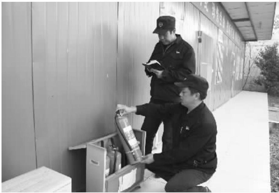
为确保冬季整备场和客车作业安全,武昌客车车辆段信阳运用车间开展了冬季消防专项检查,对场内设备防火、消防栓、灭火器等消防设备进行了全面检查,消除了火灾隐患。图为12月8日,该车间安全人员正在检查灭火器。方昉 摄
