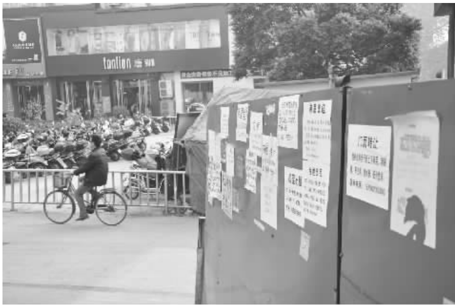
一直以来,市区街头小广告随处可见屡禁不止,严重影响了城市环境。图为在胜利路天桥施工现场,周围的隔离板上,竟也被贴上了不少小广告。 本报记者 徐杰 摄
