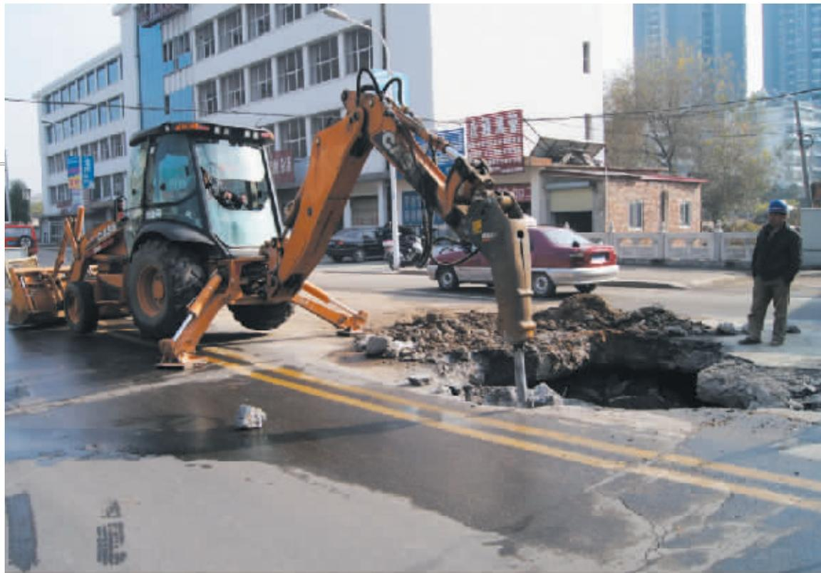
为尽快解决三里店民桥南头自来水管破损给沿线居民生活用水带来的不便,申飞市政公司积极派出机械车辆及施工人员配合自来水公司维修队伍进行管道修复工作。图为申飞市政公司凿岩机操作手正在进行路面破除工作。
