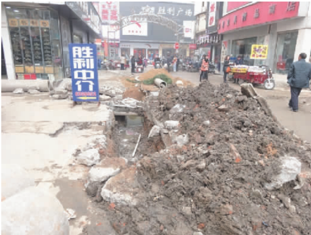
图为仍未施工的现场。
