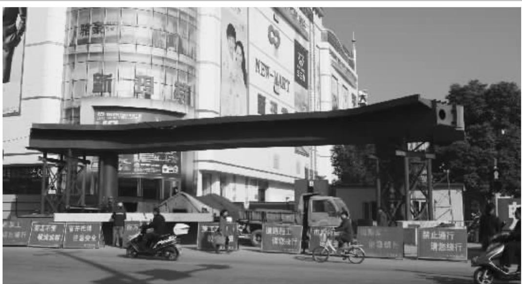
由申中市政公司承接的三小路口人行过街天桥工程,在综合执法局、建设单位、监理单位的指导关怀下,经过项目部全体成员加班加点、战酷暑、熬寒夜的努力下项目进展顺利。目前桥梁的下部结构施工全部完成,桥梁上部结构已完成第一段、第二段、第四段、第五段的主箱梁的吊装和拼接安装工作。图为已吊装拼接完成的上部钢箱桥梁主体。 周爱玲 摄
