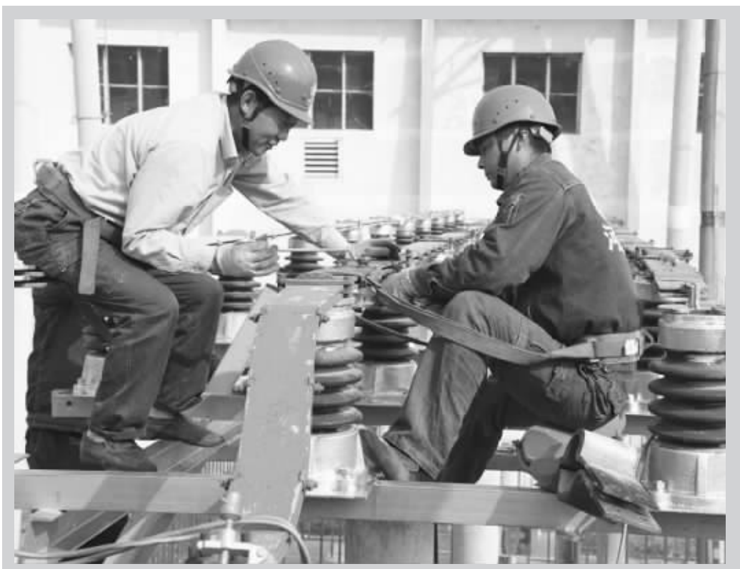
10 月 25 日,在 220 千伏潢川变电站检修现场,依然是热火朝天。检修人员正在安装调试 4 号主变压器的风冷散热片和设备防锈处理。随着该项工作的结束,该站检修将全部完成。据介绍,经过此改造,潢川变电站的供电可靠性将大大提高,为即将来临的冬季负荷高峰打下坚实的基础。图为检修现场。 甘仁伟 刘威 摄
