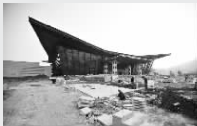
在距离北京市中心50公里的雁栖湖上,2014年亚太经合组织(APEC)领导人非正式会议的主会场正在紧张施工中。
