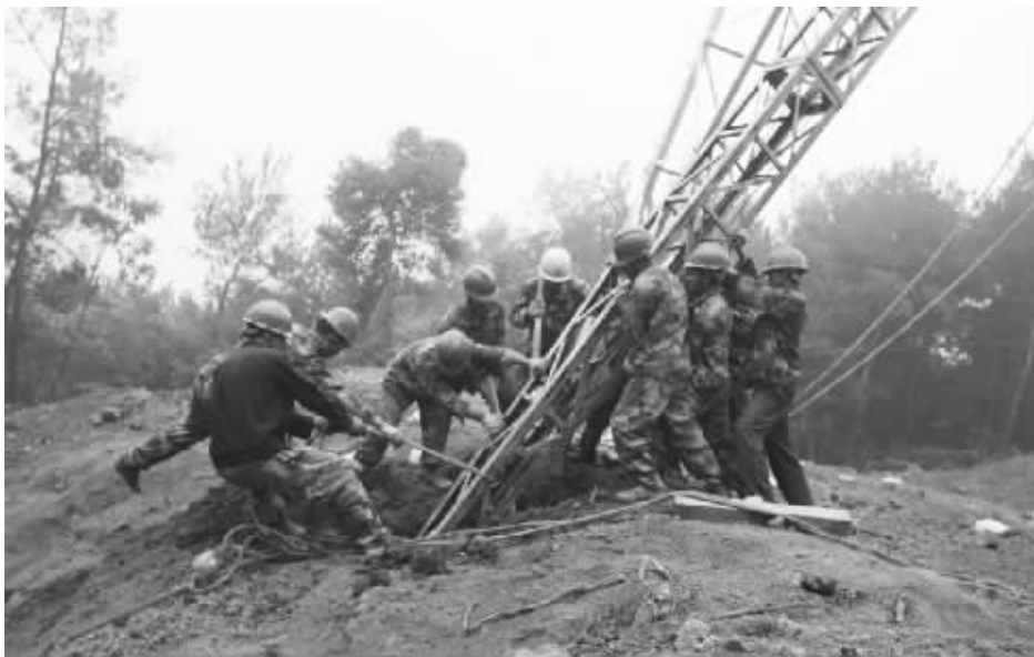
9月23日,信阳供电员工冒着小雨,继续推进220千伏沙叶线输电工程,争取此线路早日投运,为信阳电网迎峰度冬打下基础。
