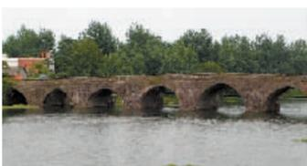
永济桥又名万金桥。位于光山县城南25公里的泼泼河镇街北头，呈南北向横跨于泼泼河上，连接泼泼河南北两岸。该桥始建于明代，为典型的联拱石桥，全部由雕琢过的花岗石条构成，建筑结构严谨，其建筑风格具有典型的南方建筑特点。永济桥是河南省最长的古代石拱桥。南北长101米，东西宽10米，桥下由9个拱形孔长度不一，自6米至12米不等，宽度和高度由中间孔向两边递减。使整座桥呈八字型。这种建筑在古代既能使桥梁顺利通过，又可以迅速排除桥面雨水，防止桥下渗透腐蚀桥梁结构。
