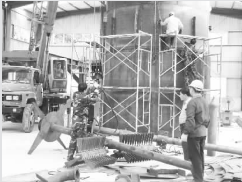
浉河区五星办事处观音山生态有机肥生产项目是我市环南湾湖上游生态环保项目,该项目总投资 1000 万元,建筑面积 4000 平方米,安装 80 吨大型发酵罐 3 个,年生生产态有机肥 2 万吨。主要是将养殖粪便经过发酵、消杀、烘干、加工转化成无污染的生态有机肥。目前,项目建设正在紧张进行,预计下月将正式投入生产运行。图为工人们正在施工时的场景。 刘文强 邱启俊 摄
