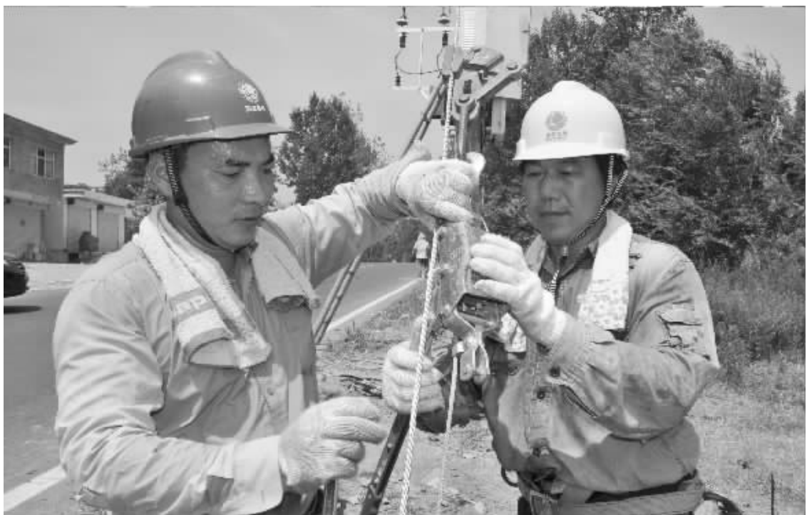
8月26日,固始县电业局员工冒着酷热,为祖师镇松林村架设线路,安装配电变压器,解决该村低电压问题。图为电业局员工正在施工时的情景。高伟 张杰 摄
