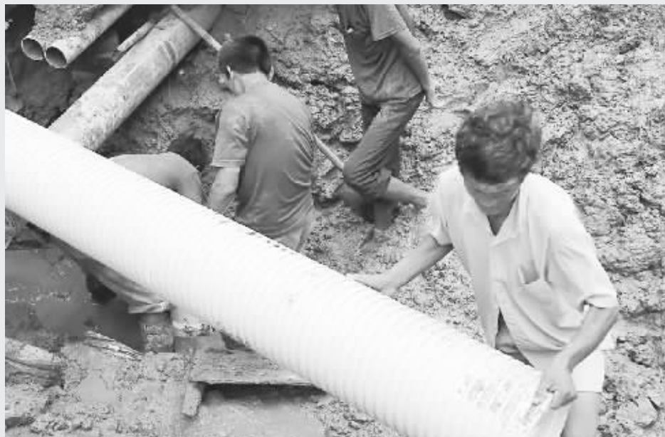
日前,罗山县青山镇街道社区下水管道的雨污分流工程正在施工。该镇投入380万元对街道社区进行提升改造,对基础设施、公共环境等进行重点整治。 方建兵 摄
