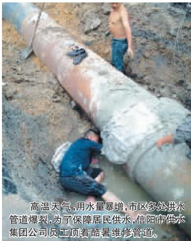
高温天气,用水量暴增,市区多处供水管道爆裂,为了保障居民供水,信阳市供水集团员工顶着酷暑维修管道。
