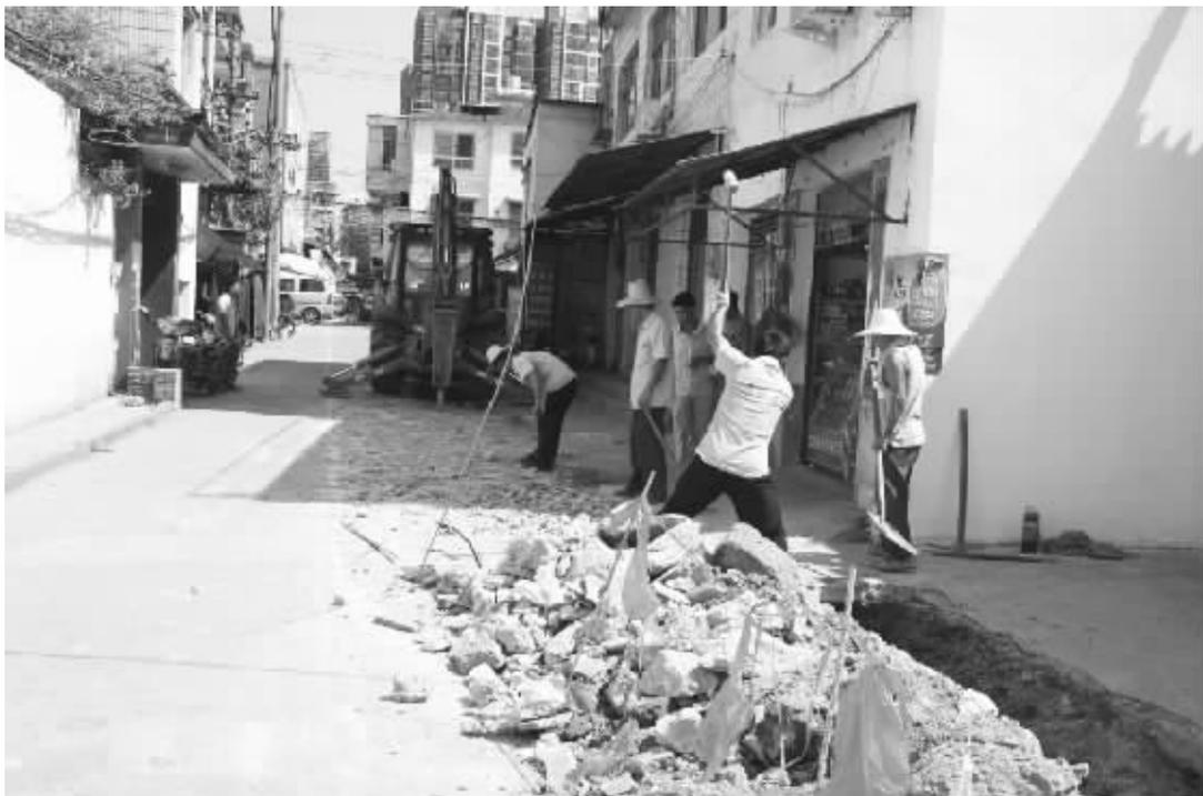
不久前的一场强降雨,令市中心城区红星社区九组内南湖路至浉河北岸胡同积水瞬间涨为“城市内河”。为从根本上解决汛期阻水问题,辖区五星办事处决定弃用淤堵在居民房屋地基下的老旧下水道,改从胡同中间重做排水系统。图为8月9日上午工人顶着烈日抡锤破路修建排水系统。
