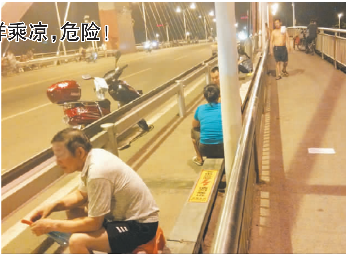
炎热的夏季，晚饭后与家人一同出来走走，吹吹凉风是很多市民的避暑方式。但是近日，记者却在民桥上发现，不少在桥上吹风的市民竟翻越围栏坐在了标有“高压危险，请勿靠近”的桥梁通电线上，看着让人胆战心惊。本报在此提醒大家，出来乘凉，安全第一，不要靠近一些危险的地方以免造成不必要的伤害。 本报记者 吴楠 摄
