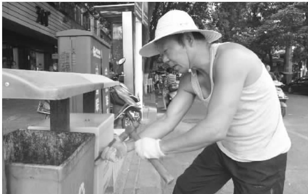
为创建省级文明城市,近日,市环卫处对市区破损的垃圾箱进行修复、更换。图为昨日上午,环卫处工作人员冒着高温,更换胜利南路一破损的垃圾箱。
