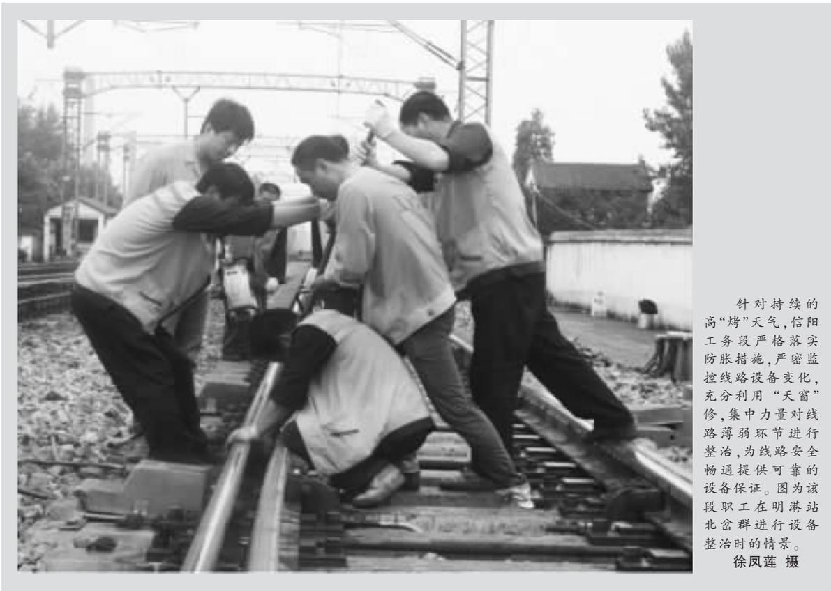
针对持续的高“烤”天气,信阳市工务段严格落实防胀措施,严密监控线路设备变化,充分利用“天窗”修,集中力量对线路薄弱环节进行整治,为线路安全畅通提供可靠的设备保证。图为该段职工在明港站北岔群进行设备整治时的情景。
