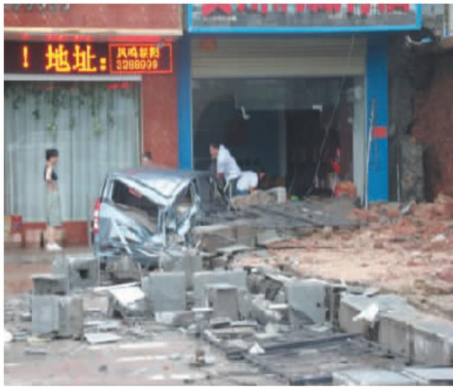
7月20日下午,位于羊山新七大道的府都花园小区门口,靠近商户一侧的楼梯外部水泥墙倒塌,砸坏了一辆面包车和附近商户的大门。据现场目击者介绍,可能是因为暴雨导致土壤松动,墙体才会倒塌。
