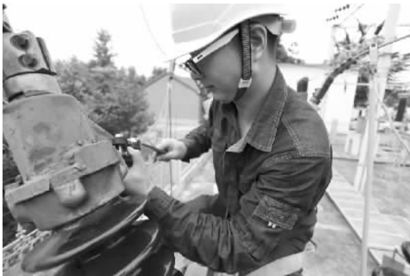
为确保迎峰度夏期间电网设备安全健康运行,7月20日,潢川县电业局实施“拂晓工程”,对全县16个变电站进行消缺。图为工作人员在35千伏白店变电站进行开关更换工作。 陈伟 摄
