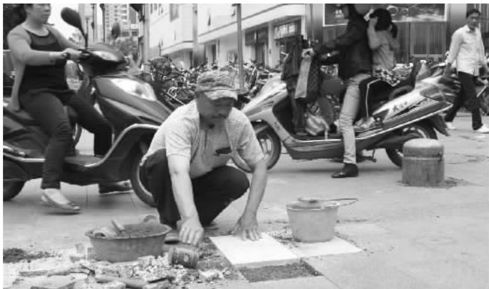
市胜利路步行街路面上的砖块经常翘起或破裂,每逢下雨,市民踩在翘起的砖块上,一不小心溅起一身污水。近日,结合我市中心城区环境卫生整治,步行街管理办公室组织民工开始修补破损的砖块。
