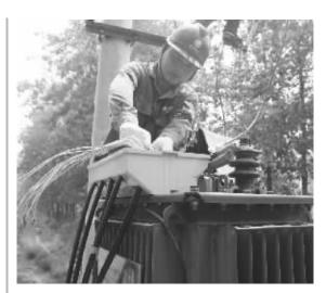
6月1日,淮滨县电业局王店供电所员工对赵营315千 伏安配变负荷进行分流。连日来,该局根据往年台区负荷和 今年变化趋势,对供电半径较大的配变负荷进行多布点分 流,确保迎峰度夏高峰时段安全可靠供电
