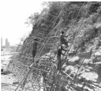
图为工人正在向龟山公园西端边坡岩体上打钢锚索。
