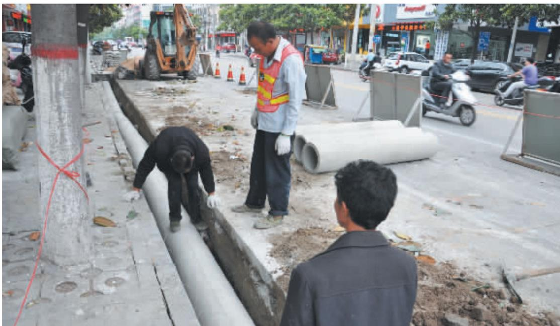
进入夏季,雨水增多,为保证城区路面排水顺畅,近日,市政部门组织施工人员对市区雨天易积水的路段展开维修,铺设新的雨水管道。图为中山路一施工现场。
