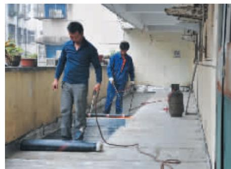
24日,本报A6版以《防水材料铺设不当 居民遭受光污染》为题报道了申碑路金杯花园小区一处楼层平台地面铺设防水材料不当,造成光污染,严重影响了居民正常生活的问题。当日早晨,该小区13号楼的居民一出门就惊喜地发现,二楼平台堆了不少修缮材料。记者到达现场时发现,两位维修人员正在铺黑色的防水材料。据正在施工的孟师傅介绍,这种材料不仅不会反光,而且还能解决一楼防水的问题,他们争取用一上午的时间把该小区两处这样的楼台修缮好。图为维修人员正在施工。
