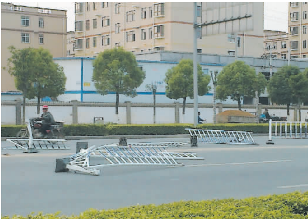
5月23日6时,市区新七大道羊山四街路段中间10多长的交通隔离栏被严重损毁,立柱和栅栏散落在马路中间(如图)。当日下午3时许,被损毁的隔离栏仍“躺”在路中没被清理。据附近的市民介绍,这个路段的隔离栏经常被疾驰的车辆撞毁。本报记者 张勇 摄
