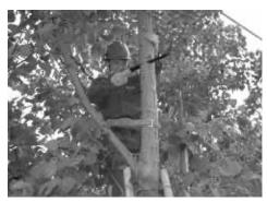
夏季到来,雨水增多,各类树木生长加快,许多 过高的树木影响着电力线路的安全运行。图为5月 19日,罗山县电业局输配电部人员对10千伏龙5 线线下树障进行修剪、清理,保障线路安全运行,
