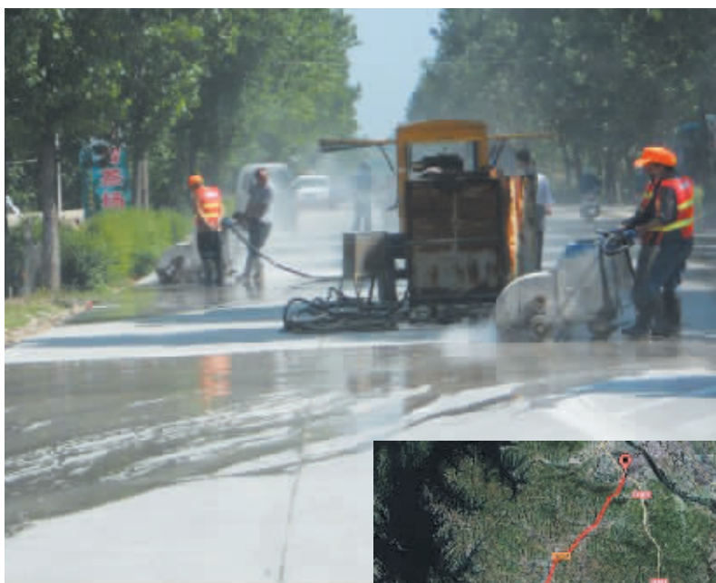
▲图为工人正在紧张施工为路面刻槽。
