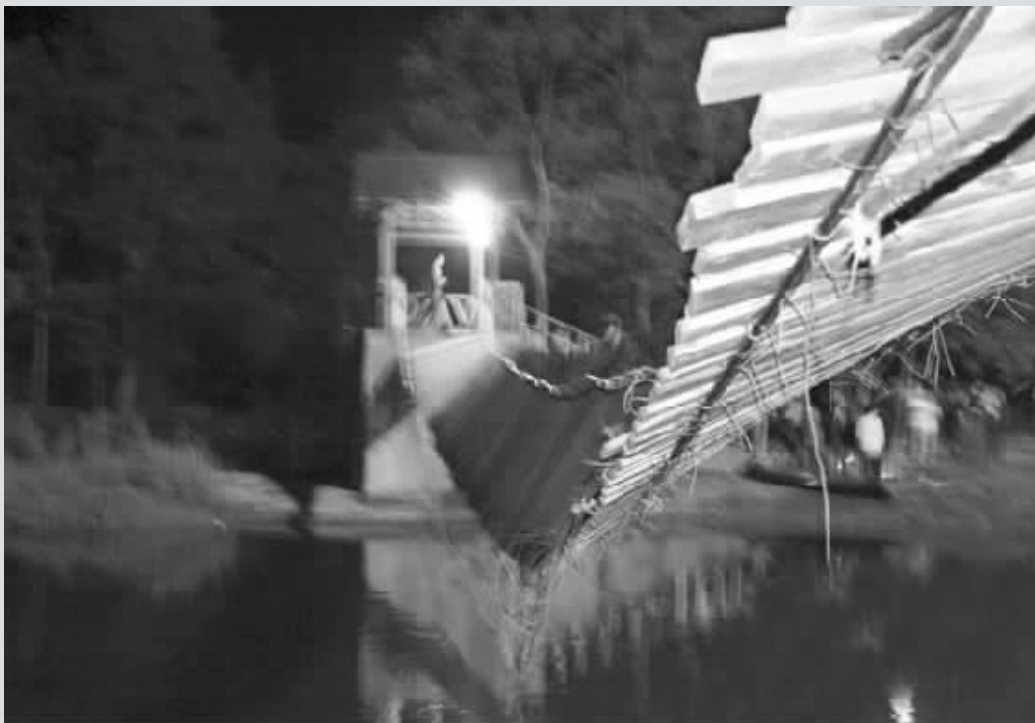
图为发生事故的跨河吊桥现场。
