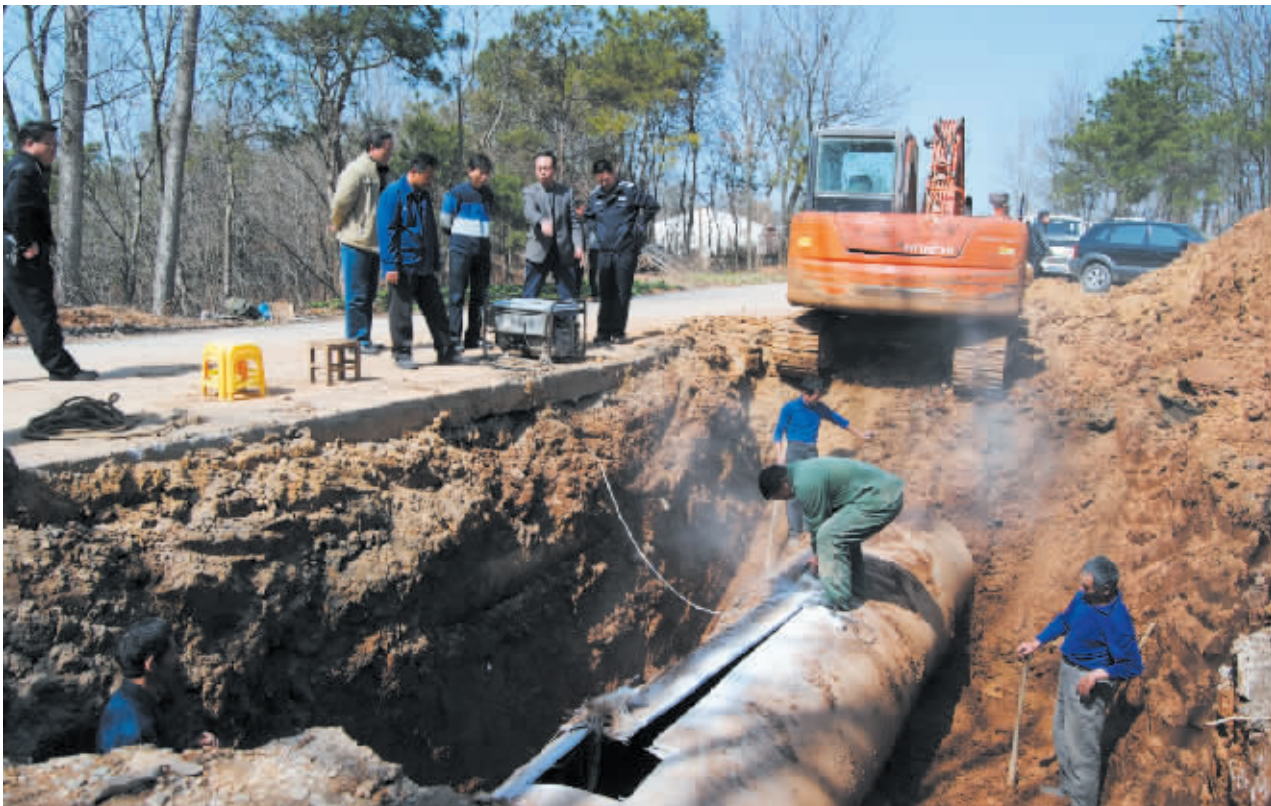
DN1200 输水主管道抢修现场
