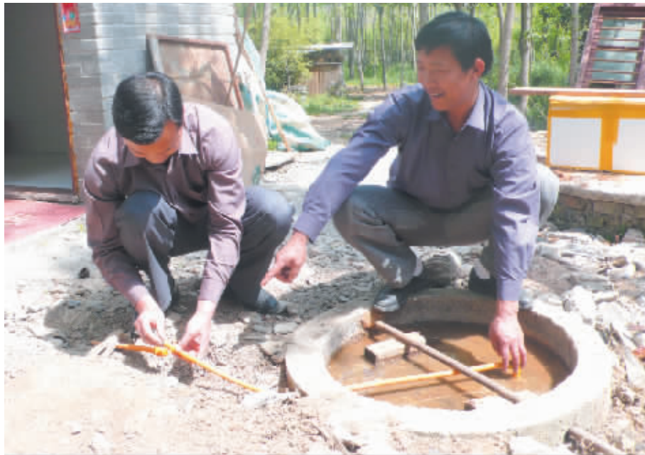
在农村沼气建设工作中,平桥区农村能源环境保护站积极把生态环境保护和农村经济生态建设相结合,认真抓出了一批高标准示范点。通过以点带面,有效地推动了该区农村沼气建设工作的全面开展。图为该站技术人员在五里办事处郝堂村为农户建好的沼气池安装调试管道阀门时的情景。 李建设 摄
