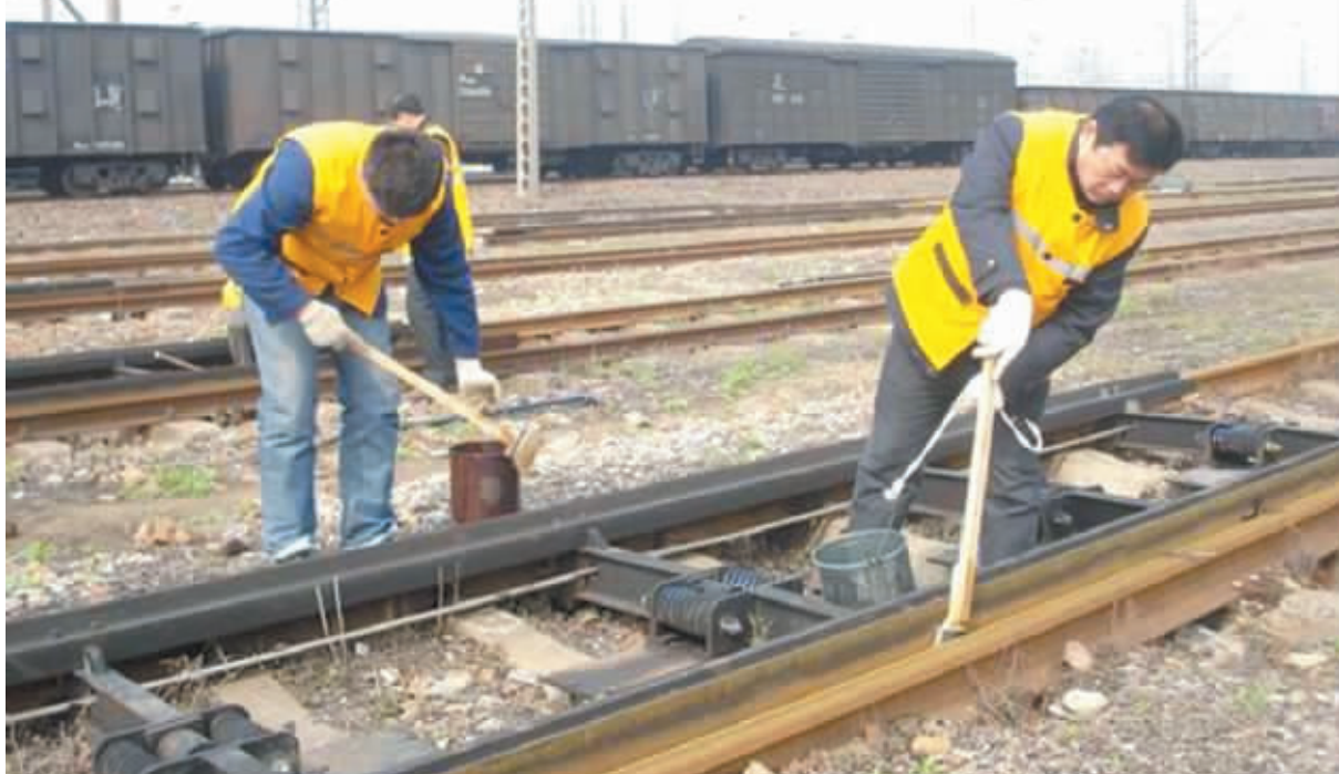
近日,信阳火车站设备维修车间强化责任,加强设备管理,完善了安全风险管理体系,对信阳北站、运转车间停车器进行了集中检查,维护设备的良好使用,推动了车站的安全生产的有序发展。图为该站职工在维修停车器。 万春苗 摄
