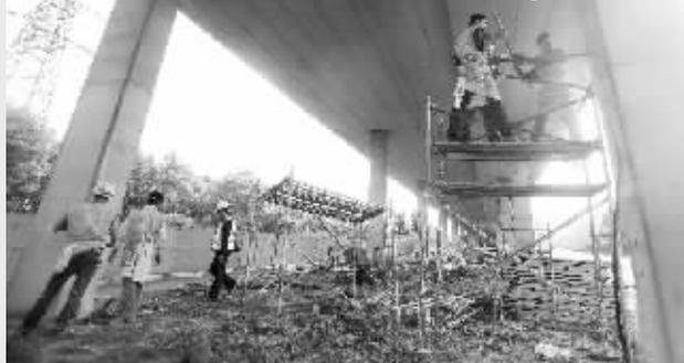
4月17日,施工人员在湖北省武汉市东风大道沌阳高架桥墩上打炮眼。近日,施工人员在位于东风大道的原“湖北第一长高架桥”沌阳高架桥进行爆破准备作业,该桥预计于5月进行爆破拆除。沌阳高架桥于1997年建成通车,全长3.476公里,曾经是湖北第一长高架桥,是武汉中心城区出城方向的重要通道,该桥因无法满足出城快速通道的需求而面临拆除。(据新华社)
