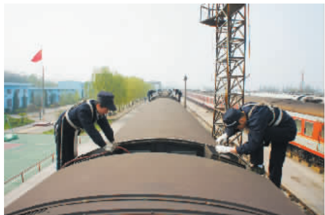
为提高空调列车舒适度,武昌客车车辆段信阳运用车间对配属空调客车开展了一次车顶空调机组专项整治,对空调机组内部进行除尘、检查、紧固、保养,并粘贴检修标记,确保空调夏季使用正常。图为该车间职工正在车顶检查空调机组。 方昉 摄
