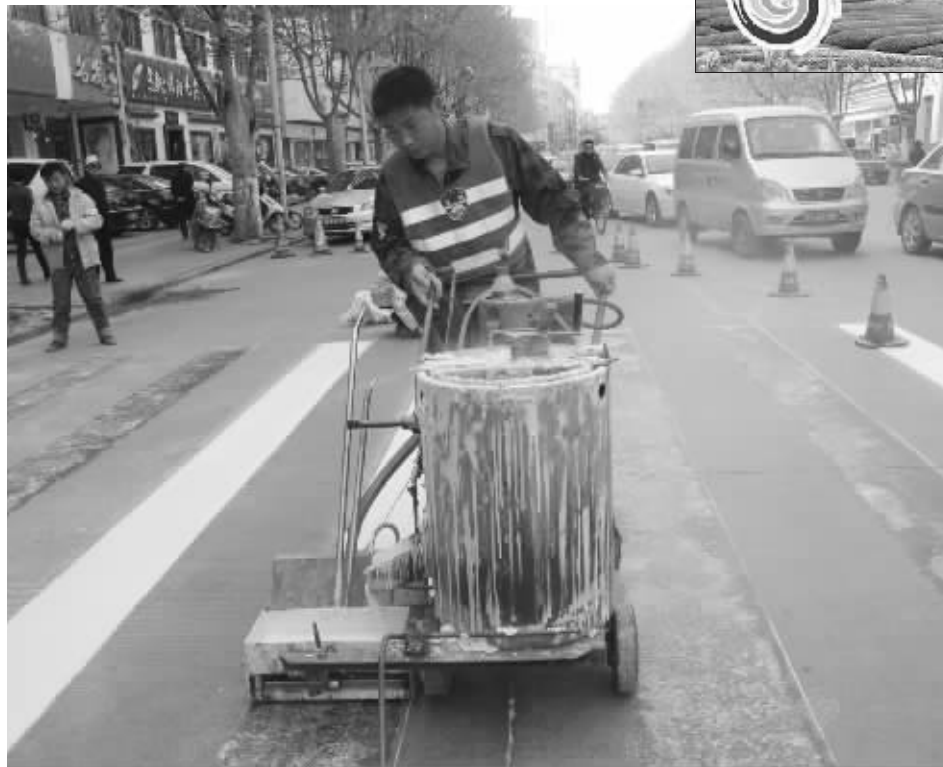
为了保障市民出行安全,美化城市交通环境,也为了迎接即将到来的茶文化节。近日,市交警支队设施科在我市的主要路口重新画上道路交通标线。图为工作人员正在画中山路上的一处斑马线。
