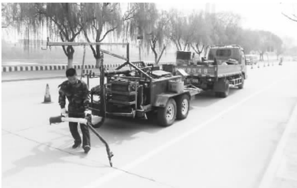
2013年第五届“信阳毛尖·龙潭杯”全国自行车公开赛开赛在即,为营造良好的赛事环境,近期以来,市城管综合执法局市政二公司按照主管局安排,精心编制施工方案,科学组织施工力量,抢天夺地对滨河南路近2500平方米破损路面进行维修,组织两台沥青灌缝设备进行路面灌缝,确保道路畅通。图为沥青灌缝时的情景。
