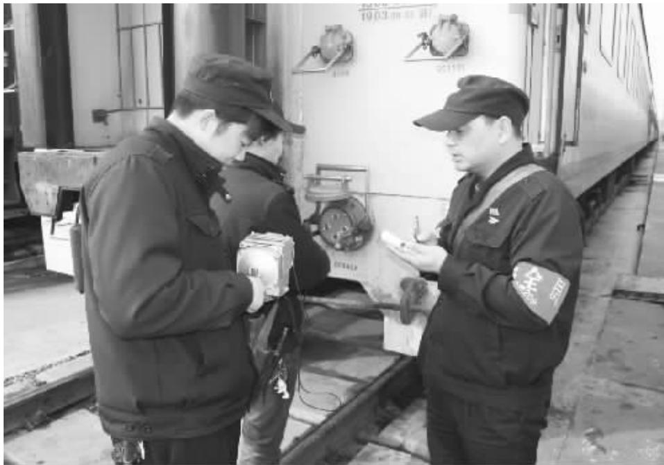
为了做好作业过程的安全卡控,武昌客车车辆段信阳运用车间充分发挥车间、班组安全员作用,采取跟班作业、盯控关键等方式,确保了作业安全和劳动安全稳定。图为该车间班组安全员正在盯控测量绝缘作业。
