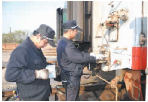
春运期间,武昌客车车辆段信阳运用车间对配属列车认真开展电器安全专项检查,确保了列车安全运营。图为车间职工正在测试列车绝缘情况。方昉 摄
