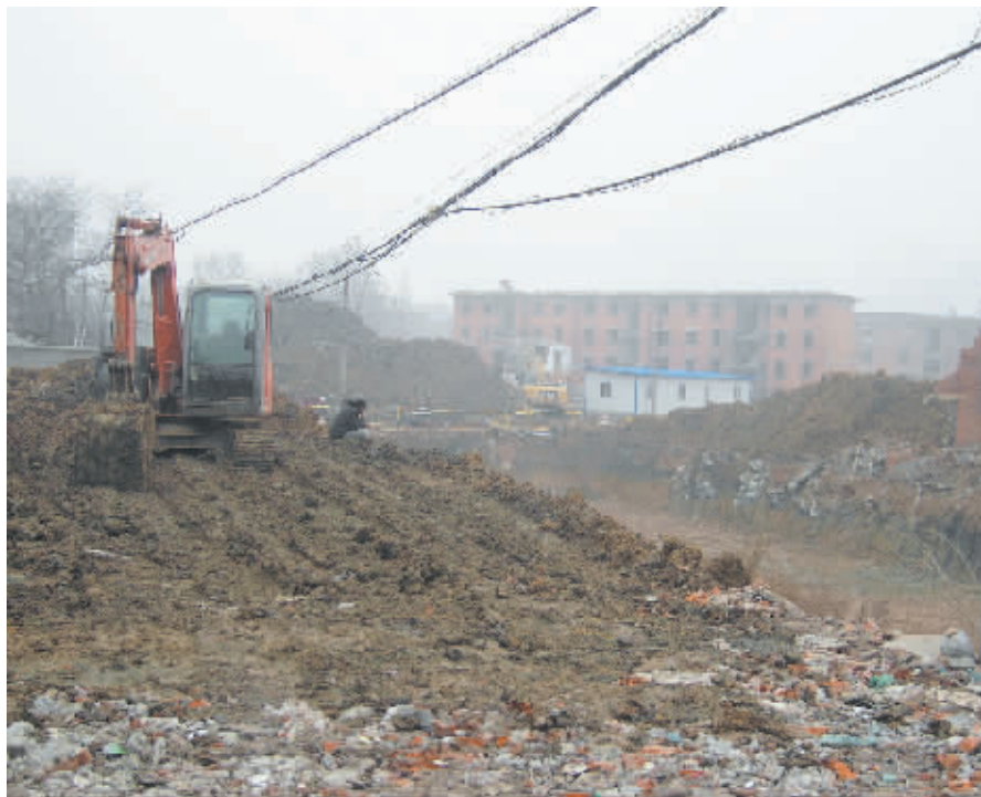
2010年11月,信阳铁路棚户区改造工程正式启动以来,进展顺利。整个改造工程包括羊山街、工人街、二七街、新八街、机务段5个项目。改造面积10.46万平方米、1458户,规划建设住房3364套、建筑面积33.81万平方米。信阳铁路棚户区改造工程是武汉铁路局推进职工保障性住房建设的一项重点工程,工程的实施,不仅对改善铁路职工居住条件、提高职工生活质量具有重要意义,而且对于完善信阳中心城区整体功能、提升城市品位、加快城镇化进程将产生深远的影响。图为工人街项目施工现场。
