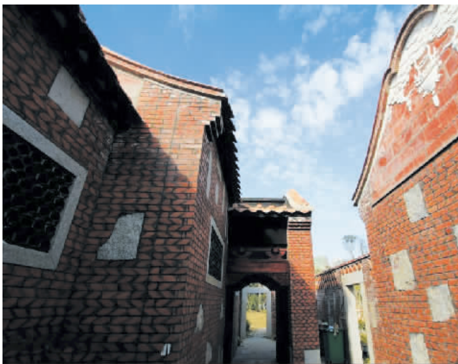
1月7日,一座最有闽南建筑“出砖入石”风格的公厕在福建省晋江市竹树下公园内建成。公厕整体以红砖搭配条石,公厕墙壁上方还有二十世纪四五十年代闽南房子的经典雕饰,瓦砾铺成的屋顶。第一次到公园的游客,肯定不会相信这就是一座公厕。(据新华网)
