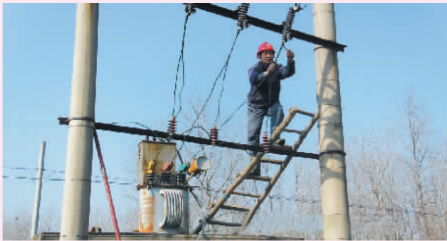
春节将至,为确保农村电力供应正常,近日,息县白土店乡电业部门克服严寒天气所带来的困难,组织人员对全乡电网进行检修。图为该乡桂庄村电工周玉友正在检修变压器。
