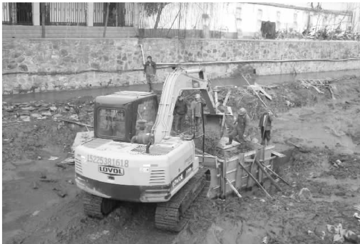
寒风凛冽,呵气成霜。为提高居民的生活质量,改善市容市貌,我市主城区内河综合治理工程之一的黑泥沟工程仍在有条不紊地施工当中,预计今年3月之前能够完工。图为昨日工人们不畏严寒、坚持作业时的情景。 见习记者 邹乐 摄
