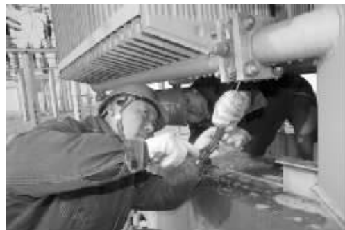
12月21日,罗山县电业局变电部顺利消除 35 千伏石山口变电站石 1 号主变渗油缺陷,确保了电力设备在冬季高负荷期间稳定运行。魏思平 摄
